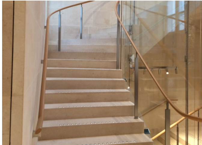
Rampe gainée, Boutique Louis Vuitton.
